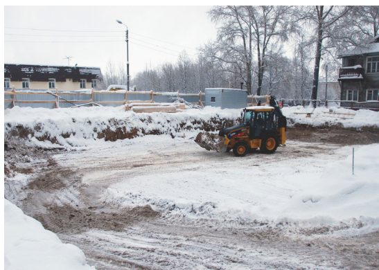
Нулевой цикл строительства энергоэффективного дома
